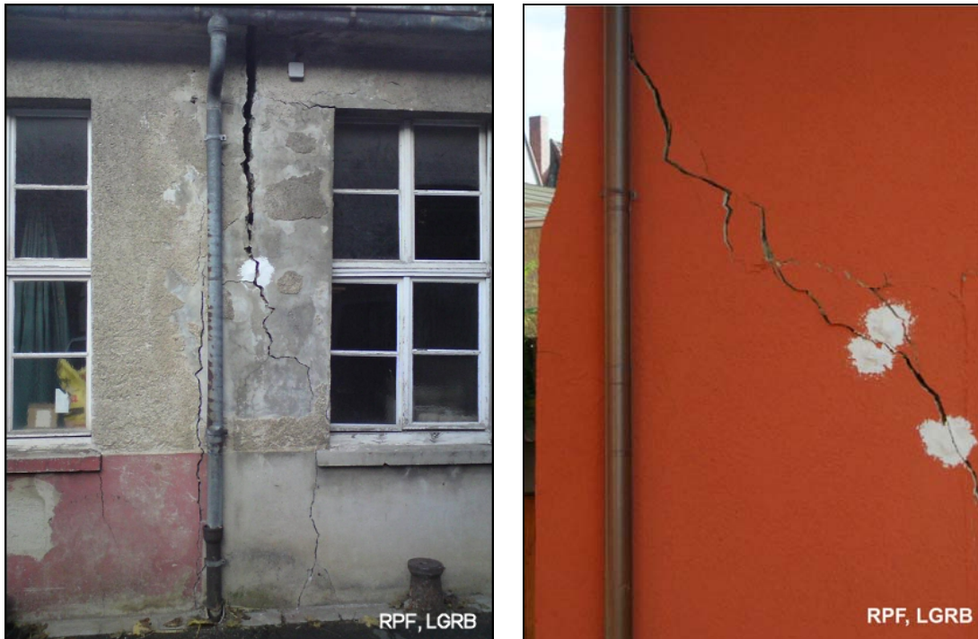
Abbildung 5-9: Hebungsrisse an Gebäuden in Staufen i. Br.
