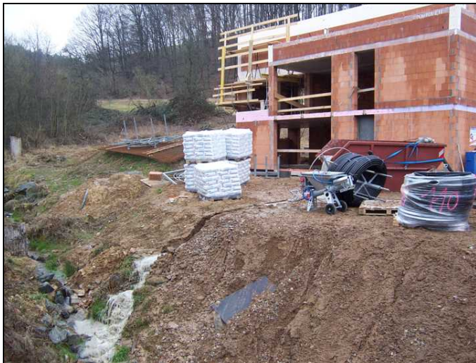
Abbildung 5-15: Verschmutzung eines Oberflächengewässers infolge einer überlaufenden Spülwanne (Foto: Rumohr).
