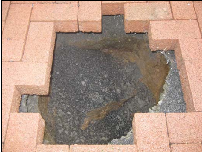
Abbildung 5-14: Setzung infolge Frostbildung in der Erdwärmesondenbohrung (Quelle: HLUG).
