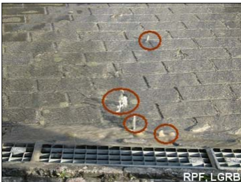
Abbildung 5-5: Artesischer Grundwasseraustritt einige Meter neben einer EWS-Bohrung.
