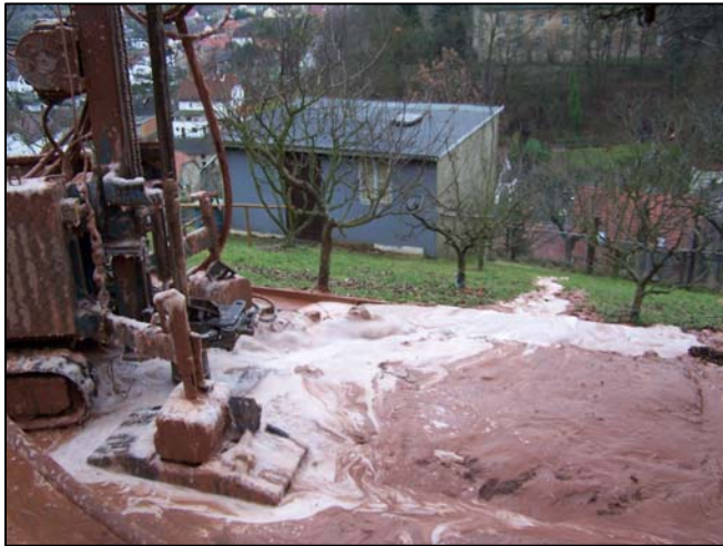
Abbildung 5-17: Verschmutzung eines Grundstücks durch unkontrolliertes Ableiten von Bohrspülungswasser inkl. bohrlochstabilisierender schäumungsaktiver Substanzen (Quelle: TLUG).
